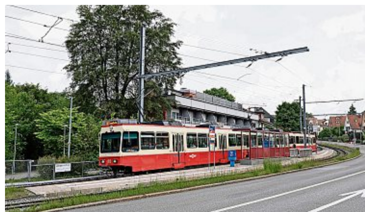
Das vordere Gleis der Station Waldburg soll während der Bauarbeiten als Strasse fungieren. Foto: Moritz Hager
