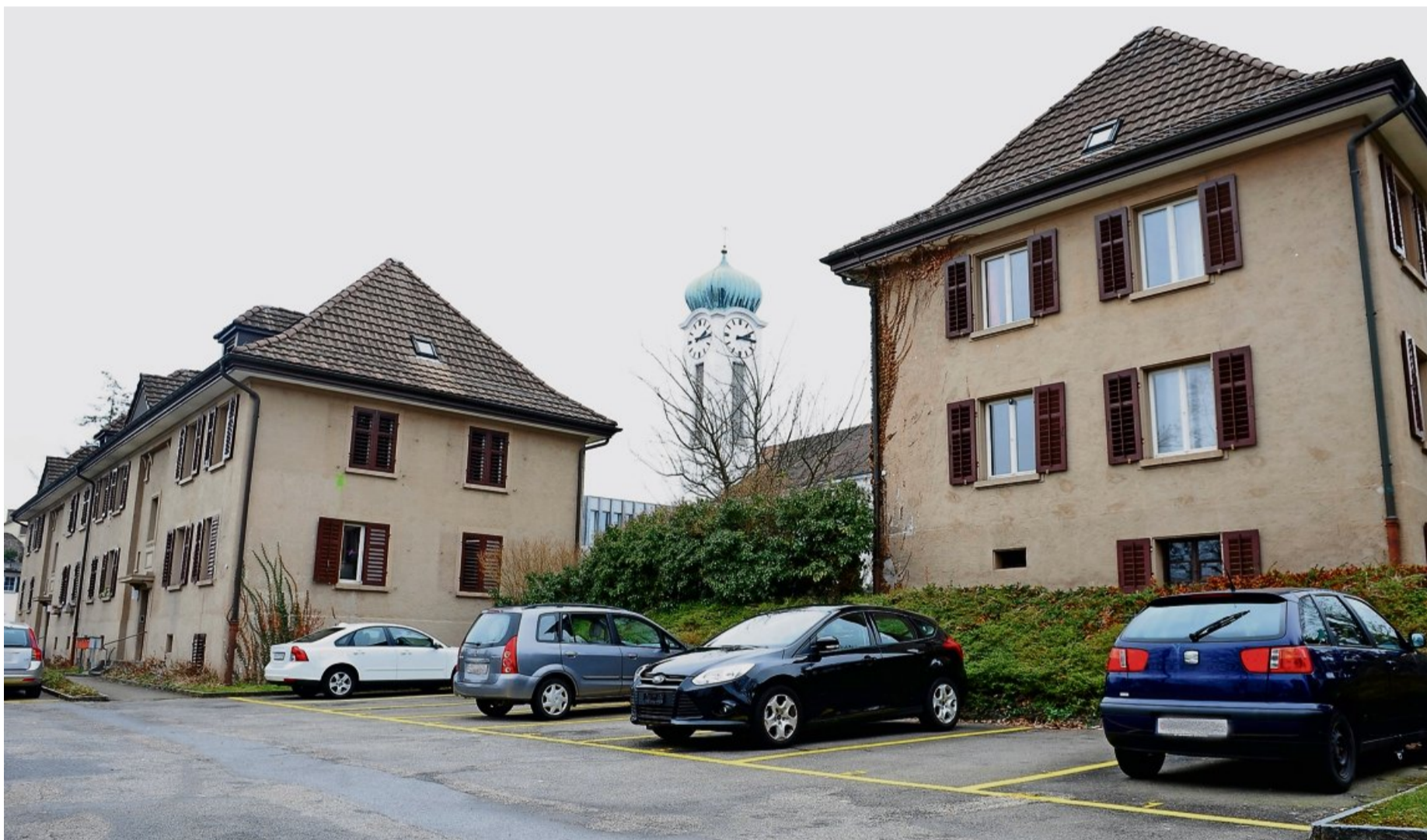
Diese beiden Gebäude der Siedlung Breiteli zählen zusammen 15 Sozialwohnungen. Voraussichtlich ab April werden die Häuser abgerissen und durch vier Neubauten ersetzt. Archivfoto: Kurt Heuberger
